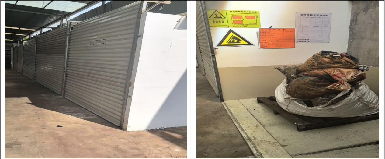
图 4-4 废物贮存间建设情况
