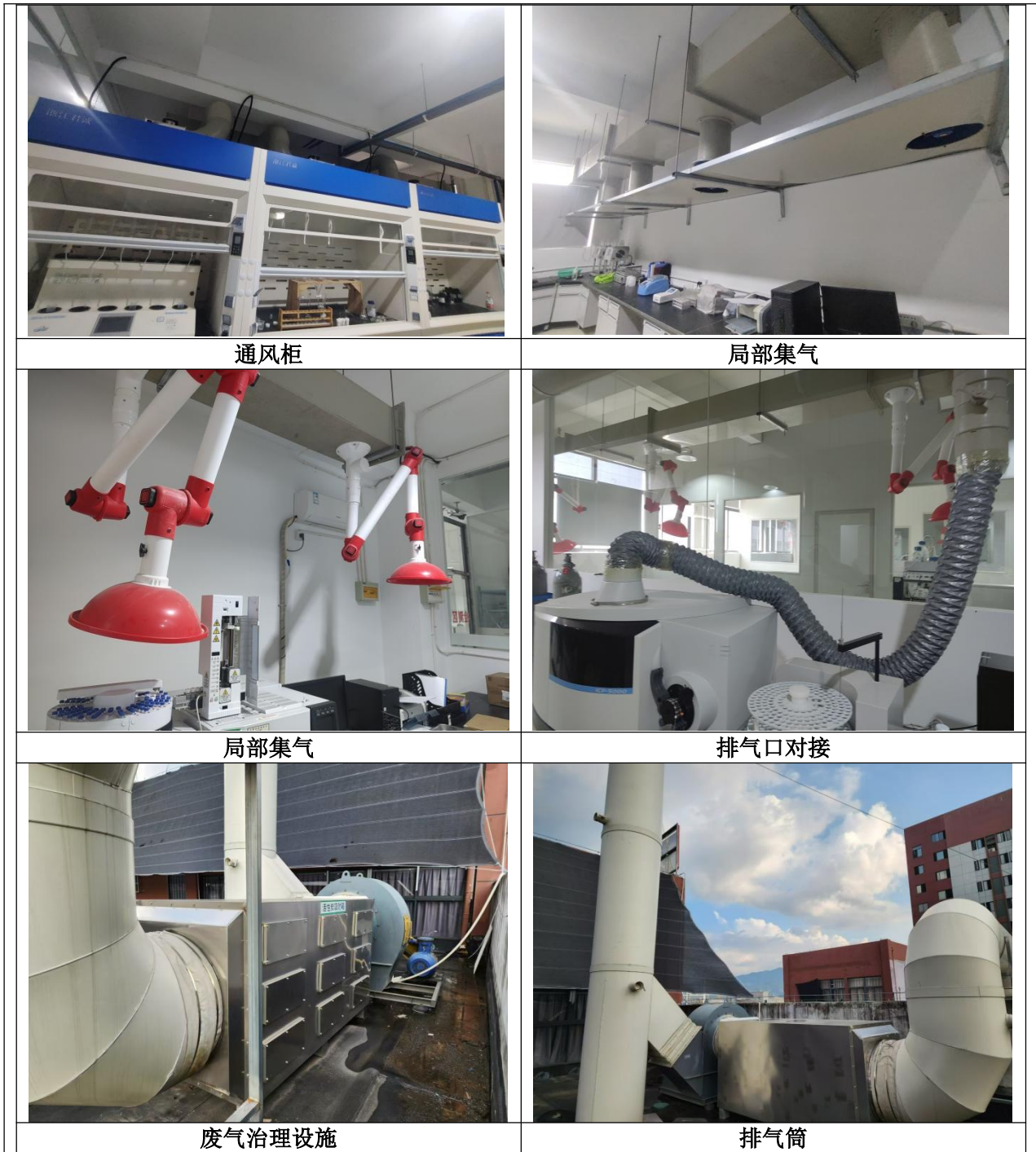
图 3-2 废气产污结点和处理设施现场图
