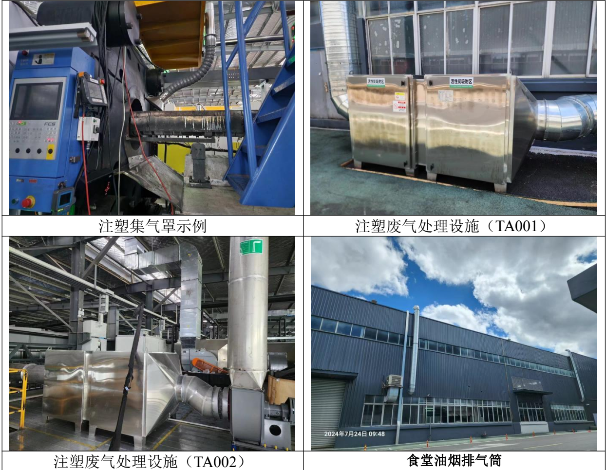
图 3-2 废气产污节点及处理设施
