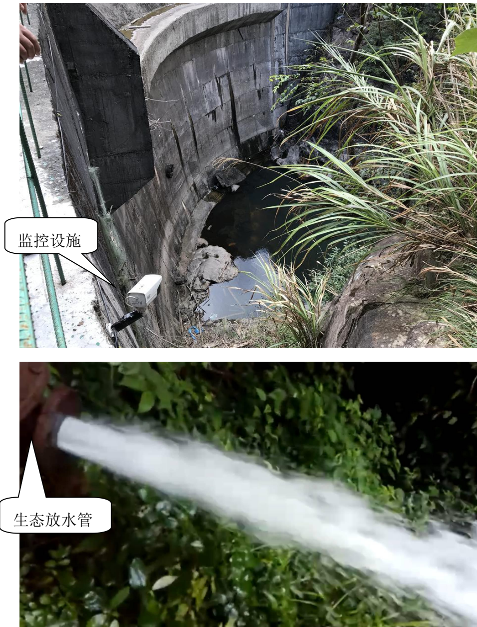
图 4-1 泄流管现场图
