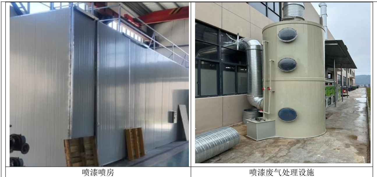
图 4-4 现场防治情况
