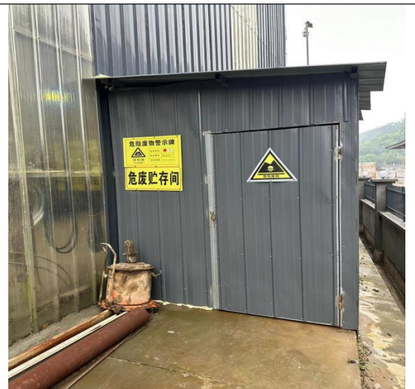
危废收集暂存间
