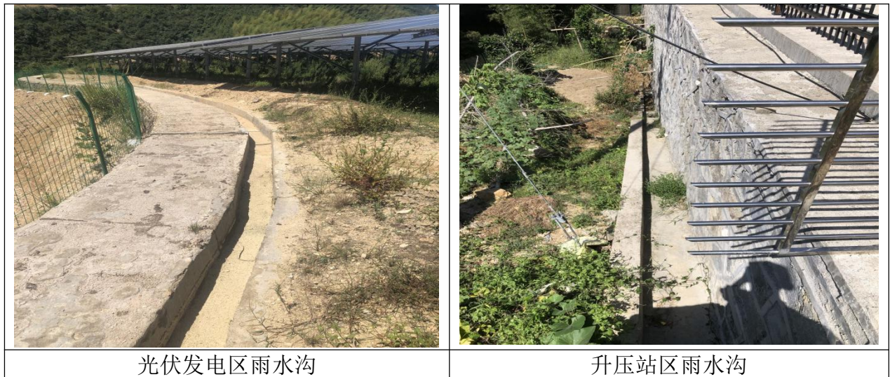
图 2-8 冲洗水收集处理现场图
