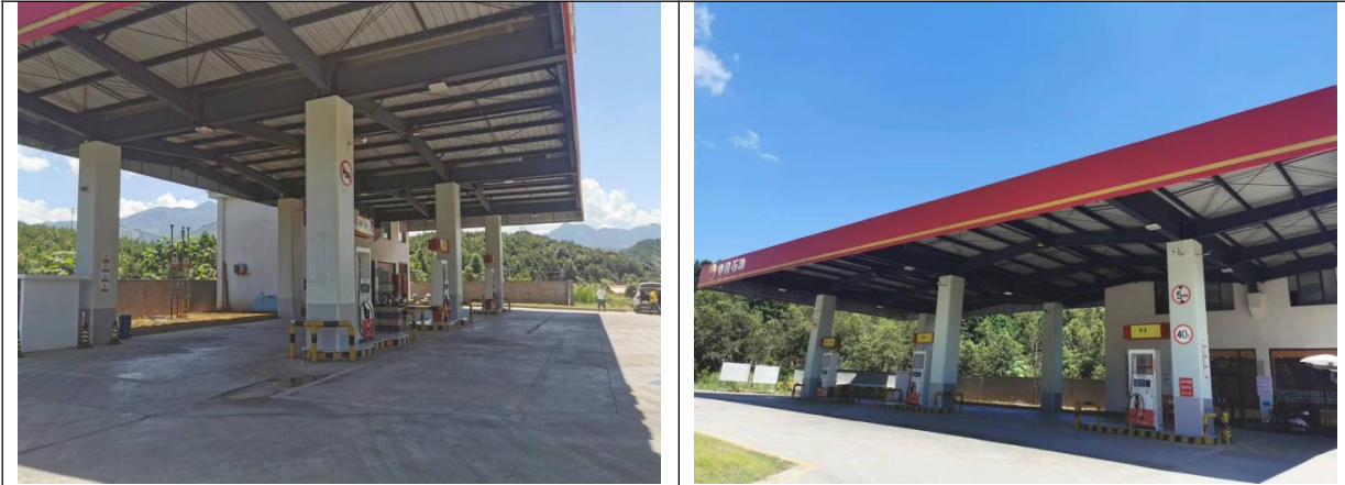
图 3-5 项目加油区现场图
