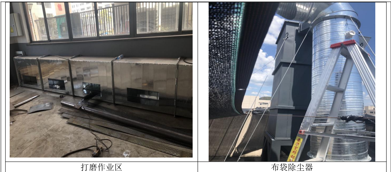
图 4-4 现场防治情况
