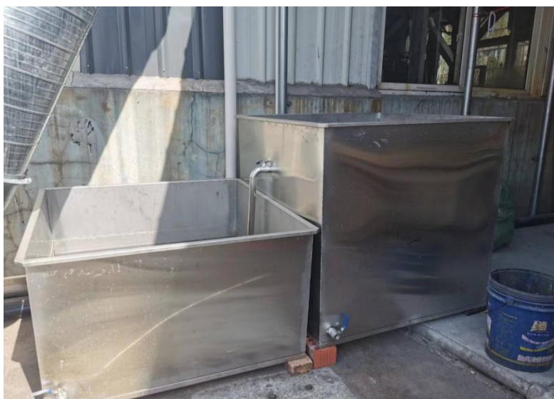
图 3-1 污水沉淀池现场图
