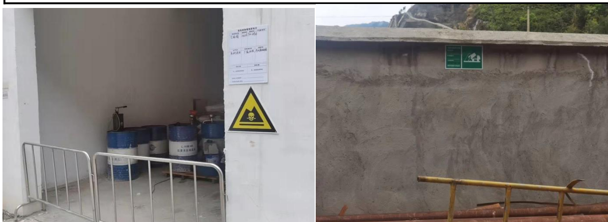
图 3-4 空桶存放间和一般固废暂存处
