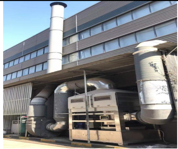
机器人焊接3#水喷淋处理设施
