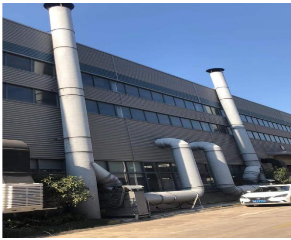
机器人焊接1#、2#排气筒
