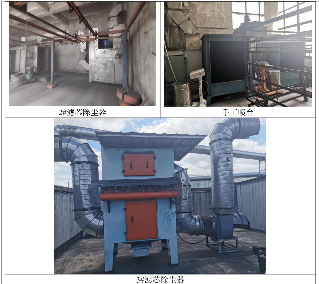
图 3-4 喷塑工序产污结点与处理设施
