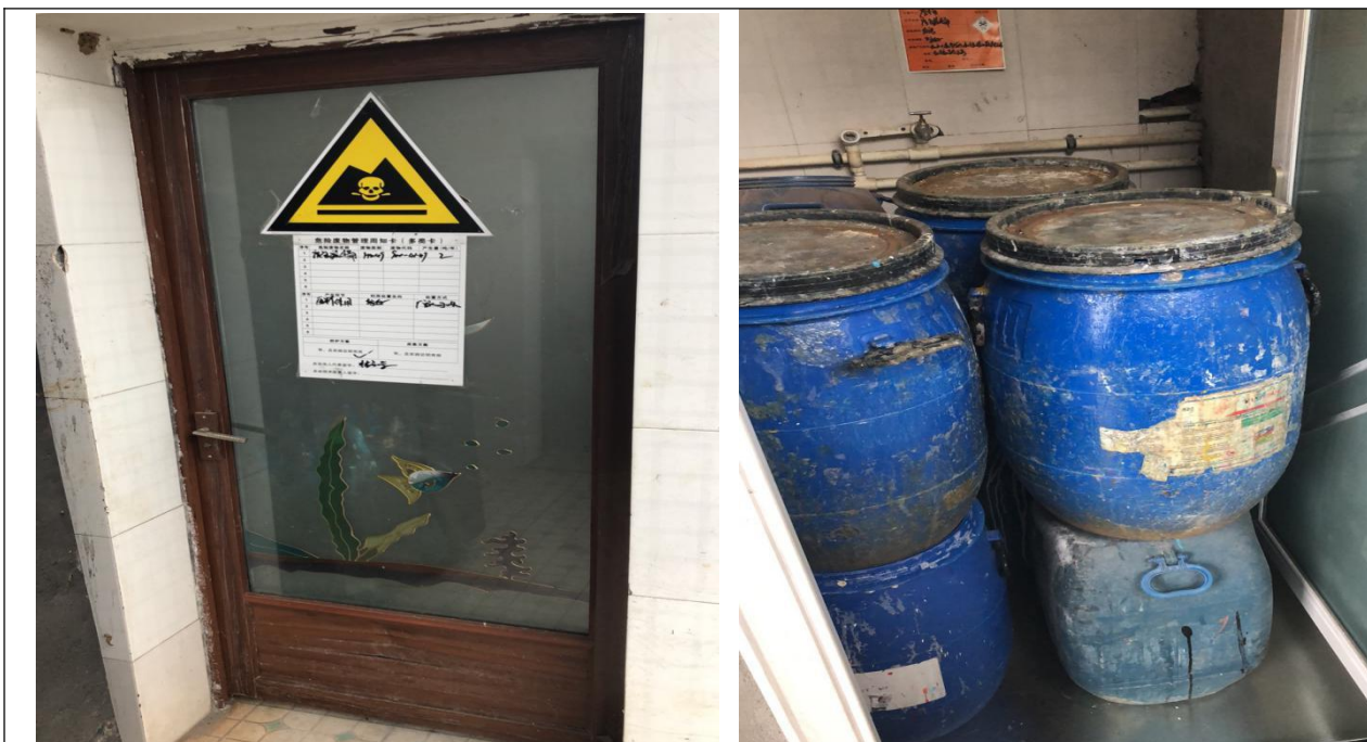
图 4-4 项目危废间情况
