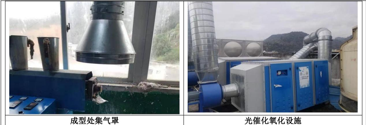
图 4-1 项目废气产污结点和处理设施现场图
