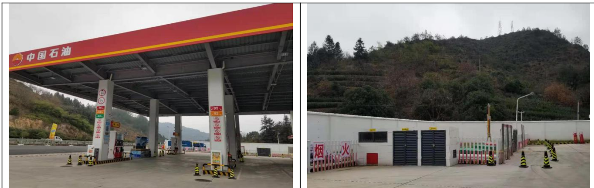
图 3-8 项目加油区、油罐区现场图
