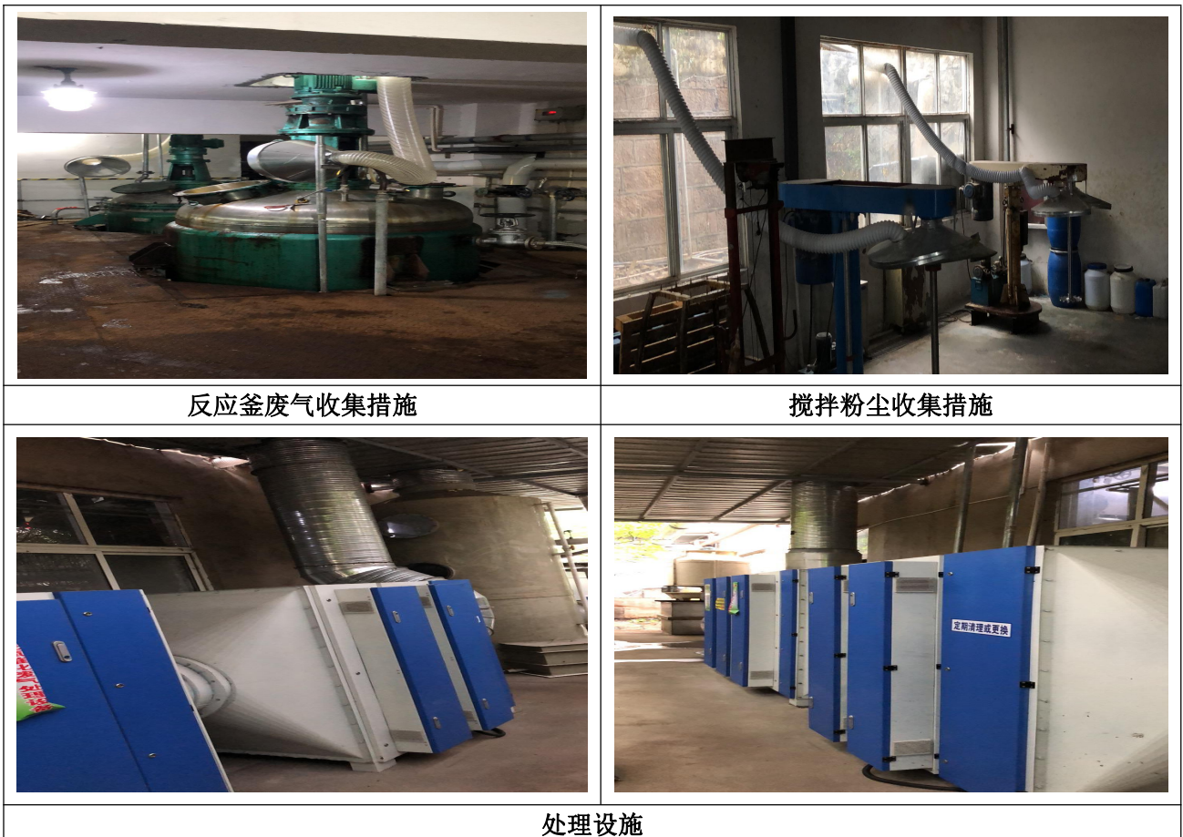
图 6-2 项目废气治理现场情况
