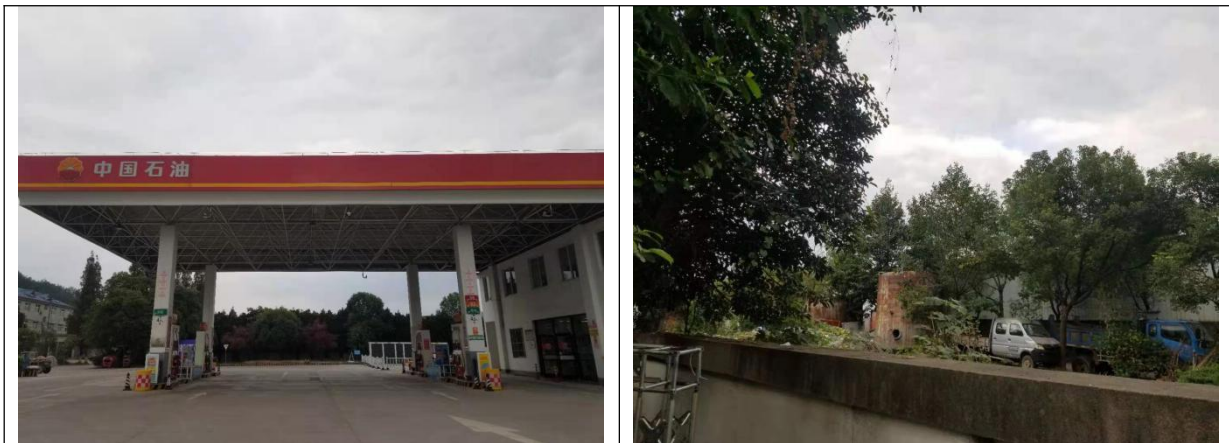
图 4-4 项目加油区、挡墙现场图
