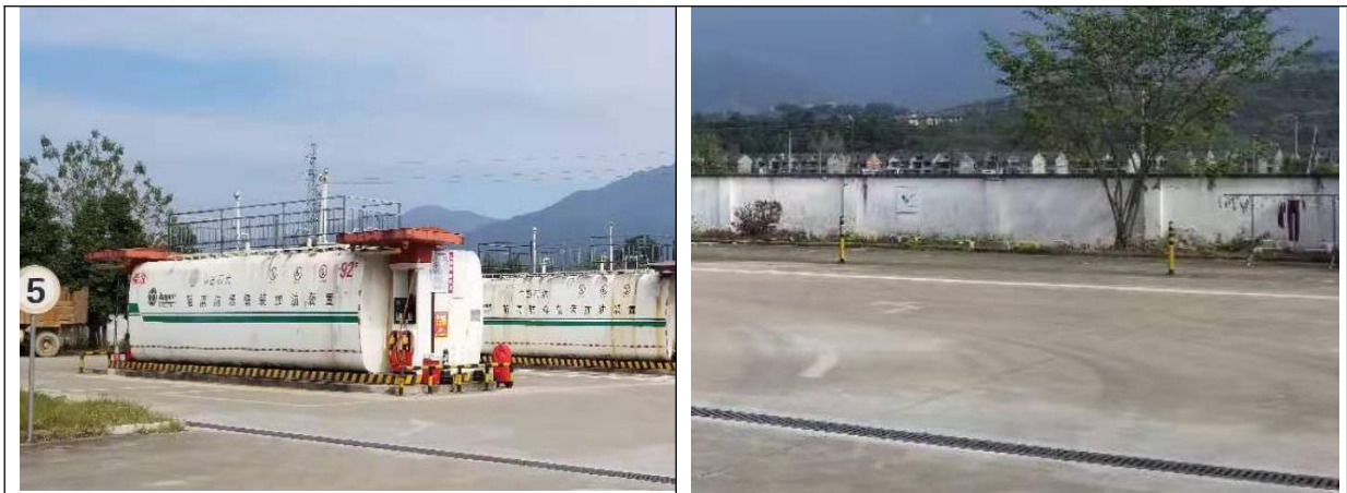
图 4-4 项目加油区、挡墙现场图
