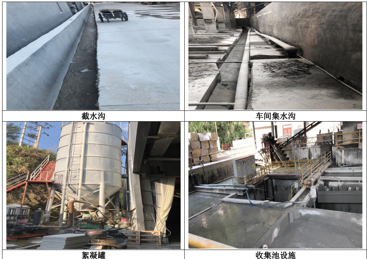
图 4-2 项目废水治理现场情况
