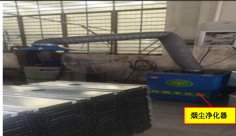
打磨、焊接工序防治措施 图 4-2 项目废气现场防治图
