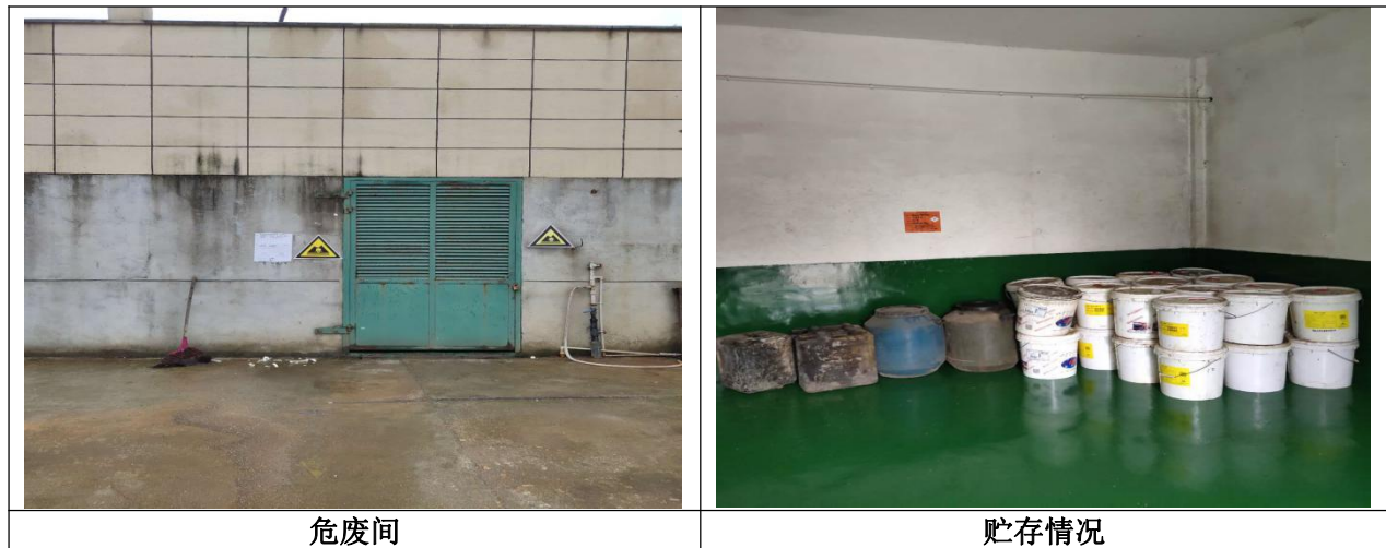
图 4-6 危废间防治情况
