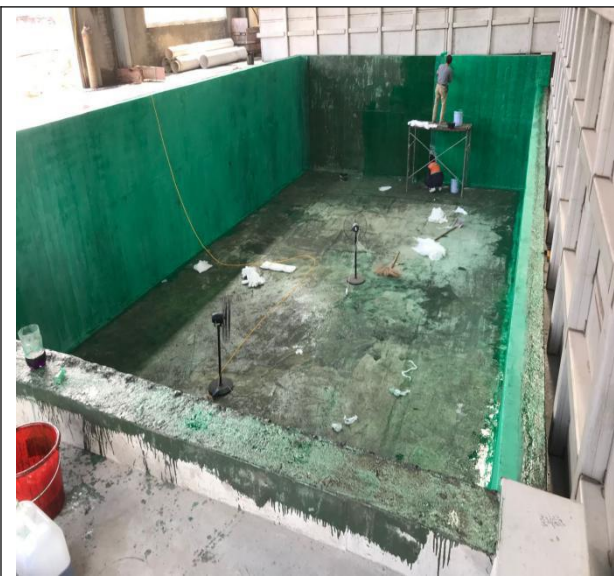
施工现场情况
