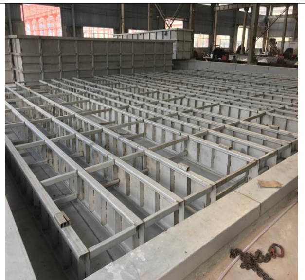
施工现场情况
