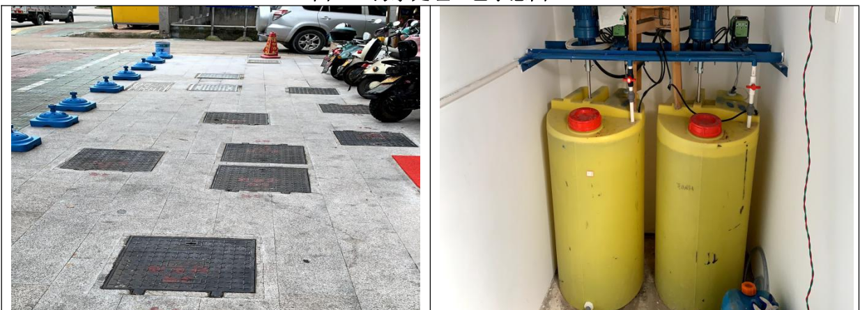
图 4-2 污水处理设施现场图
