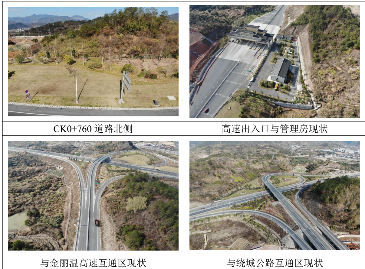
图 2-2 项目工程航拍图
