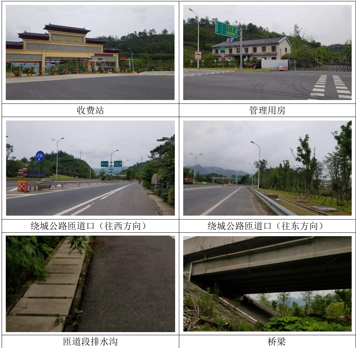
图 2-3 主要土建工程实景图
