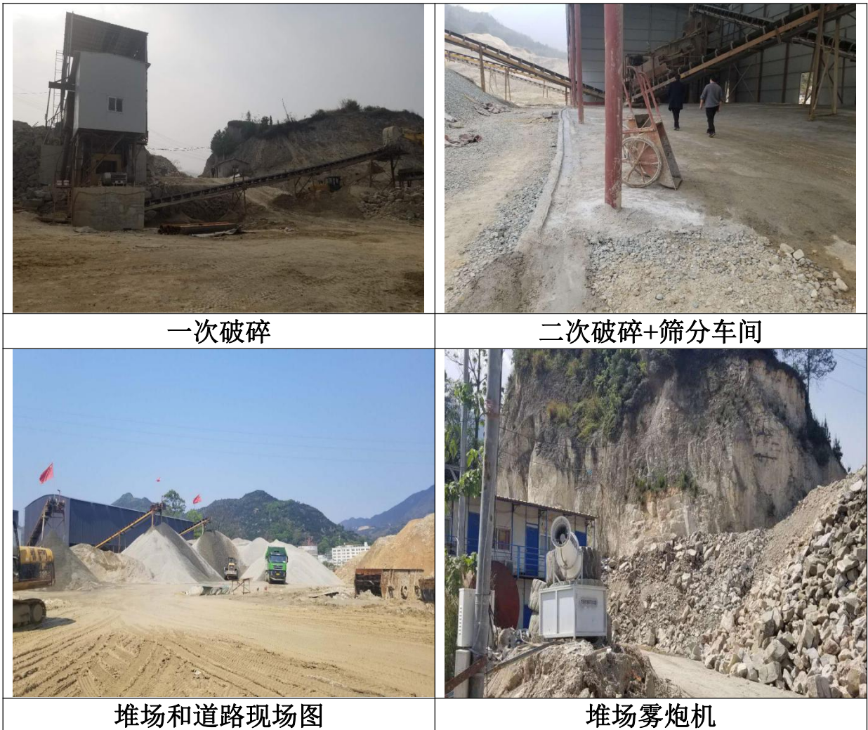
图 4-3 厂区内废气产污结点现场图
