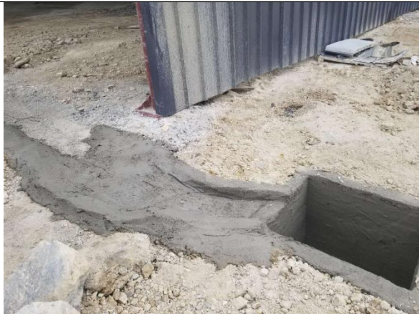
车间外小型收集池
