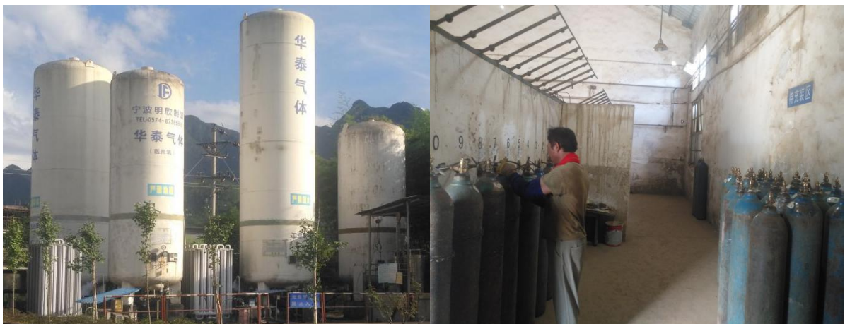
图 4-1 项目罐区、充装车间现场图
