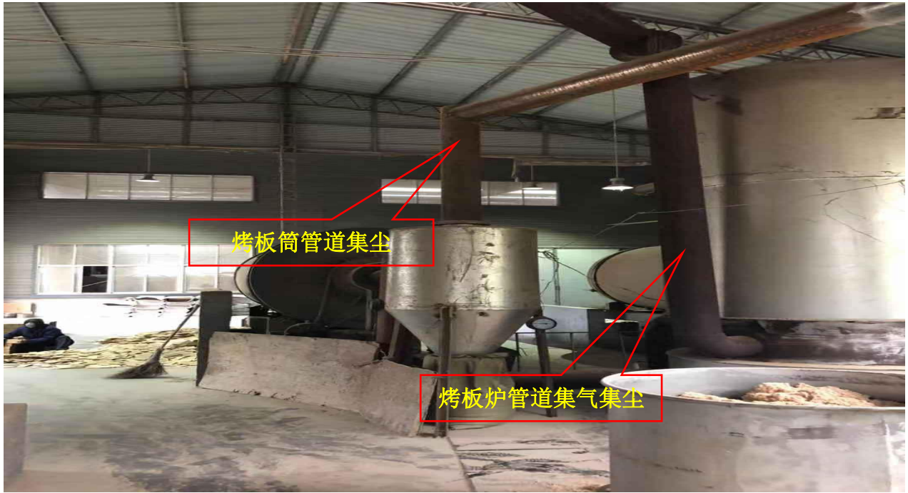
图 3-8 项目烤板车间现场情况
